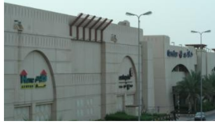
شكل (١١): لافتة مستأجر معلقة بشكل متكامل مع واجهة البناية
